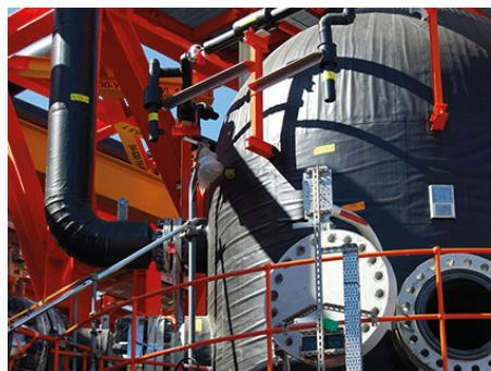
Изоляционная система на основе вспененного каучука K-FLEX с готовым полимерным покрытием IN CLAD, стойким к агрессивной морской атмосфере, ультрафиолету и механическим повреждениям. Это идеальный материал для промышленных предприятий, морских нефтяных платформ, плавучих нефтеперерабатывающих заводов, терминалов хранения сжиженного природного газа и судостроения.
